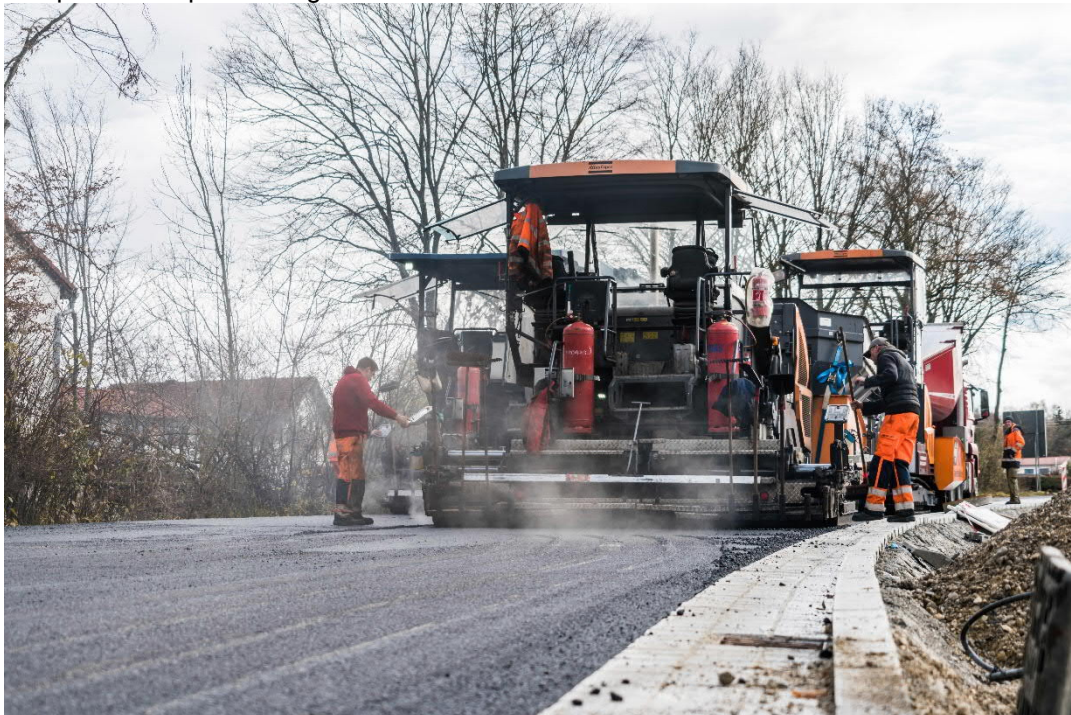
Beispielfoto: Asphaltierungsarbeiten B13 OD Fahrzenhausen / Großnöbich 2018
