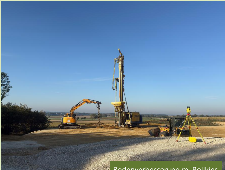
Bodenverbesserung m. Rollkies
